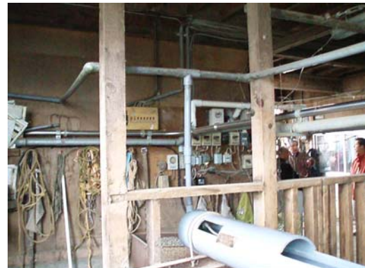
<水道管との接続部分>
