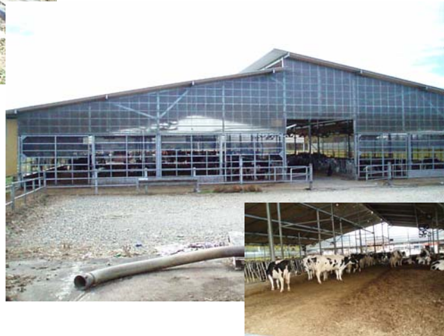
<新築したフリーバース方式の牛舎と誘導柵>
